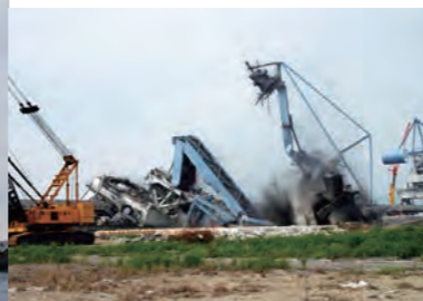
卸载机拆除工作
